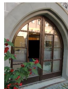
Eingang Bürgeramt Postplatz Wangen
